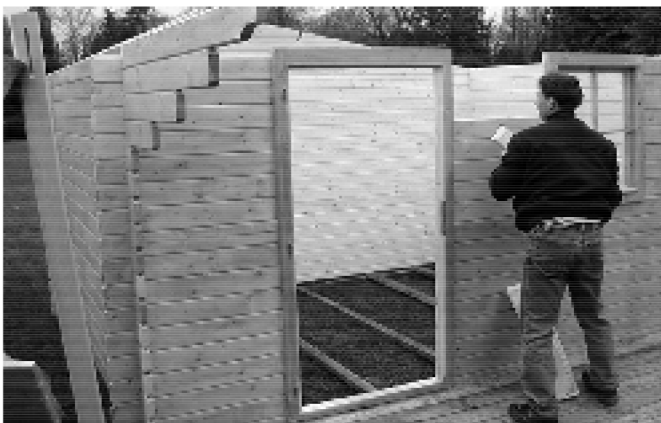
Instalovaná obložka dveří, doplnění stěnovnic do konečné výšky stěny
