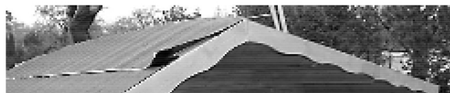
Překrytí hřebene lepenkou
