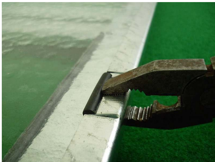
Pomocí kleští jemně přitlačíme příchytku (poz. 83-
