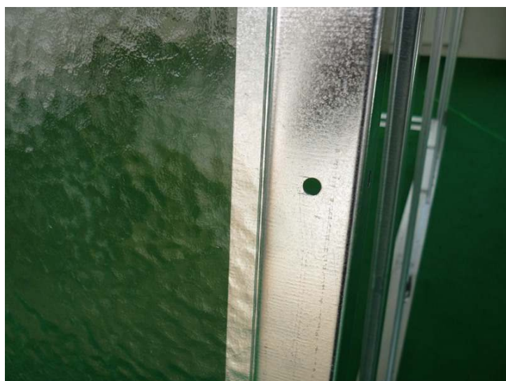
Přichycení bočního skla přičtykou poz. 83-1
