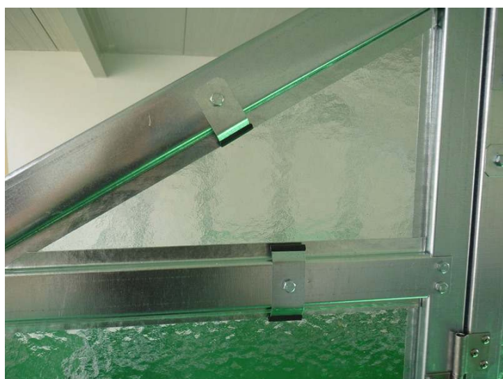
Přichycení skla k pozici 72 přičtykou 83-1 a 83-2
