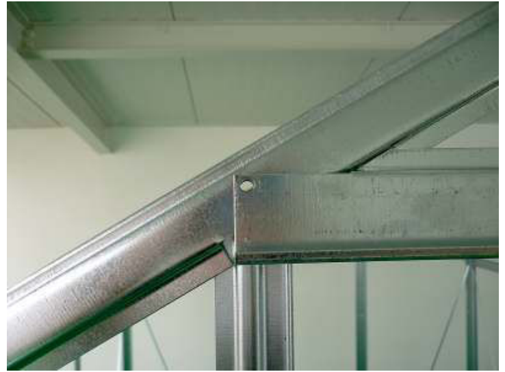
Spojení sloupku ke vstupu s střešním rohovým sloupkem a příčkou nad vstup (9L,P; 8L,P; 12) Pomocí šroubů M6x10 a matek M6 spojíme jednotlivé díly k sobě viz obrázky.
