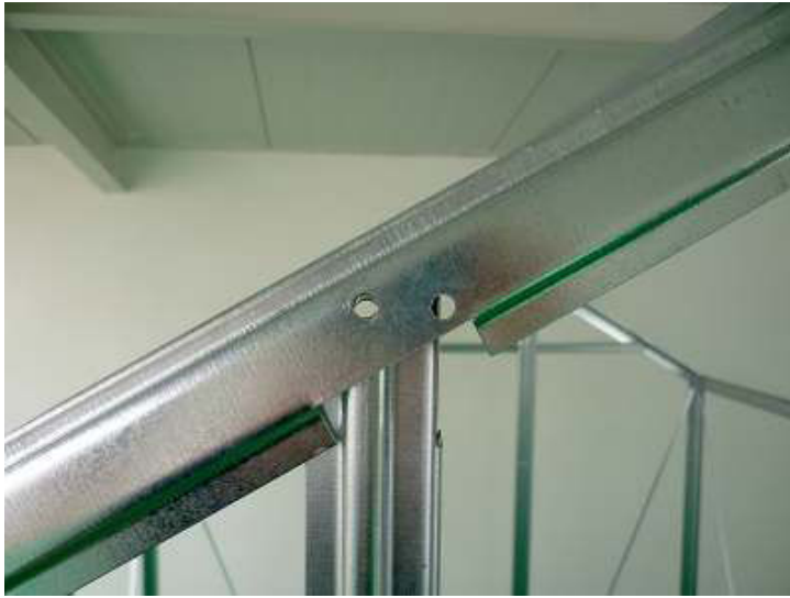
Spojení sloupku ke vstupu s střešním rohovým sloupkem a příčkou nad vstup (9L,P; 8L,P; 12) Pomocí šroubů M6x10 a matek M6 spojíme jednotlivé díly k sobě viz obrázky.
